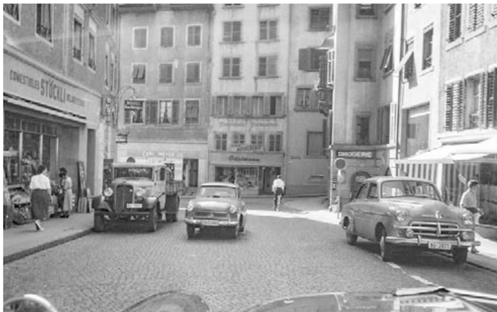
41 Die Altstadt von Bremgarten in den 1950er-Jahren. Seit den 1930er-Jahren existierten Pläne für eine Umfahrung. Die Fertigstellung der Autobahn 1971 brachte nur wenig Entlastung. 1994 wurde die Nordtangente eröffnet. Nun blieb vielen Geschäften die Laufkundschaft aus, nicht zuletzt, weil am Stadtrand grosse Ladenflächen realisiert wurden. Ein gleiches Schicksal erlebten auch die Altstädte von Brugg oder Laufenburg.
