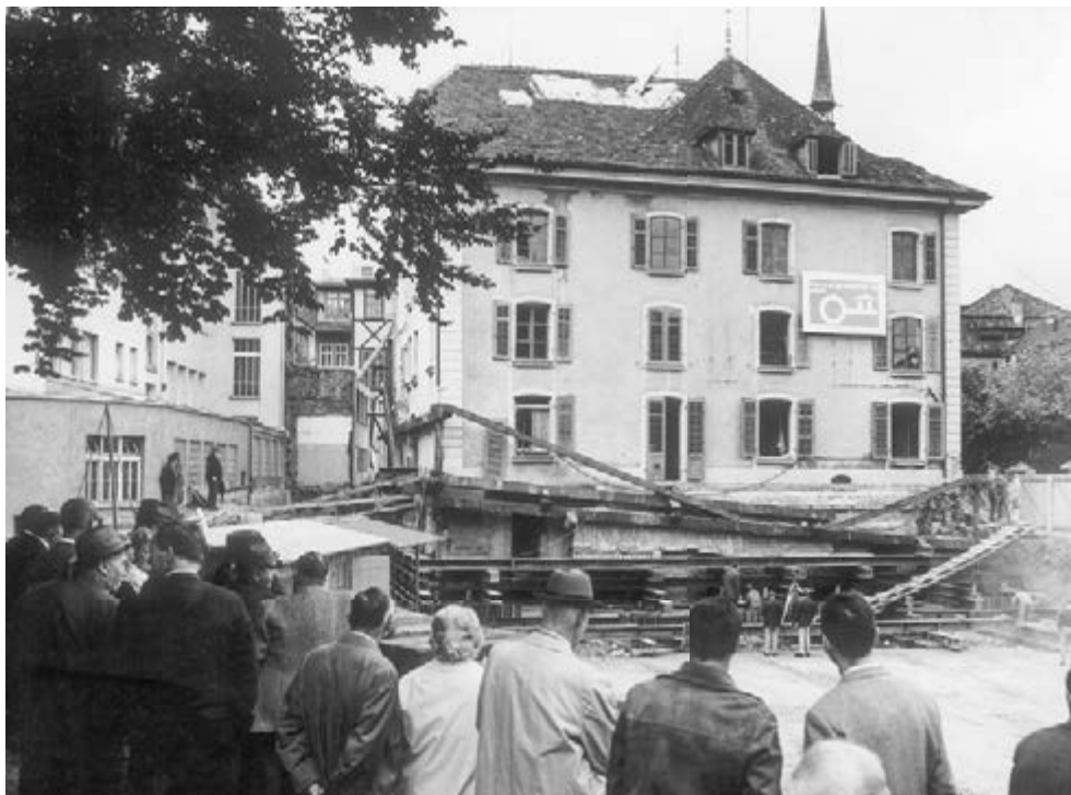
47 Die Verschiebung des Hübscherhauses am Rande der Aarauer Altstadt 1968 war eine ingenieurtechnische Meisterleistung. An seiner Stelle wurde 1970 das Warenhaus Oscar Weber eröffnet. Der Neubau diente der Generalunternehmung Horta als Werbesujet.
