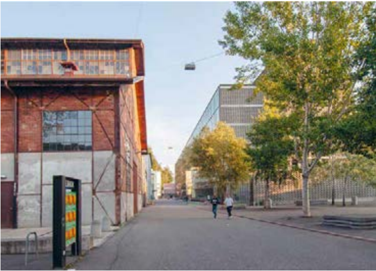
82 Baden Nord mit der Alten Schmiede (links) und dem Berufsschulhaus heute. Die denkmalgeschützte Alte Schmiede, erbaut 1906, gehört zu den letzten gründerzeitlichen Bauten aus der BBC-Ära. Sie wird heute für die Jugendarbeit und als Eventhalle genutzt. Das Berufsschulhaus von Burkard Meyer Architekten entstand 2006.
