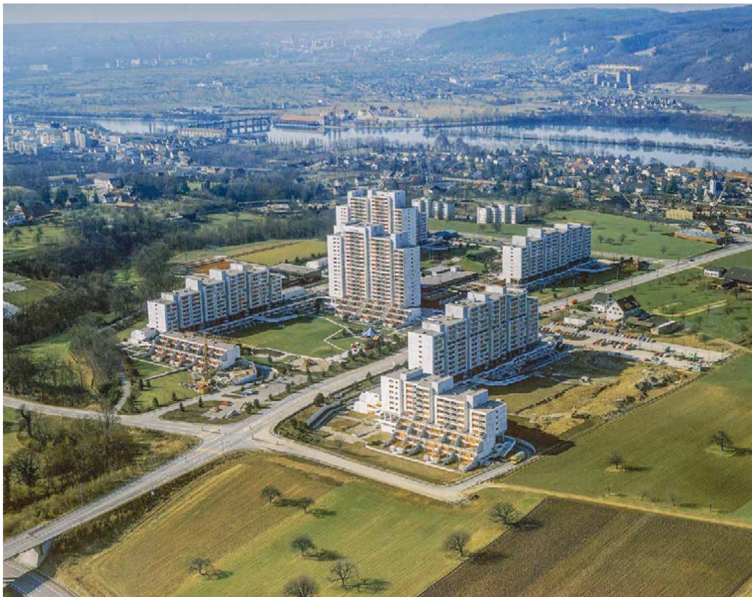
72 Die Grossüberbauung Liebrüti in Kaiseraugst, Flugbild von 1979. Die 860 Wohnungen wurden in lediglich zehn wuchtigen Baukörpern realisiert, die über ein ausgeklügeltes Wegnetz miteinander verbunden sind. Die Ausnutzungsziffer beträgt über das ganze Areal 0,9, was ihm eine städtische Anmutung verleiht.
