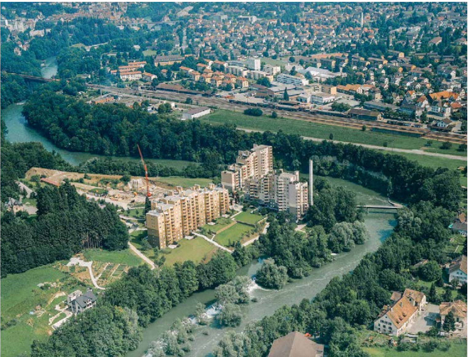
71 Baustelle «Webermühle», Neuenhof 1981. Vorbereitungsarbeiten für den letzten und grössten Wohnblock. In der «Webermühle» findet sich in Analogie zur «Telli» die stirnseitige Staffelung der Baukörper wieder. Entwickelt wurde dieses Prinzip bei der Grossüberbauung Sonnhalde in Regensdorf.
