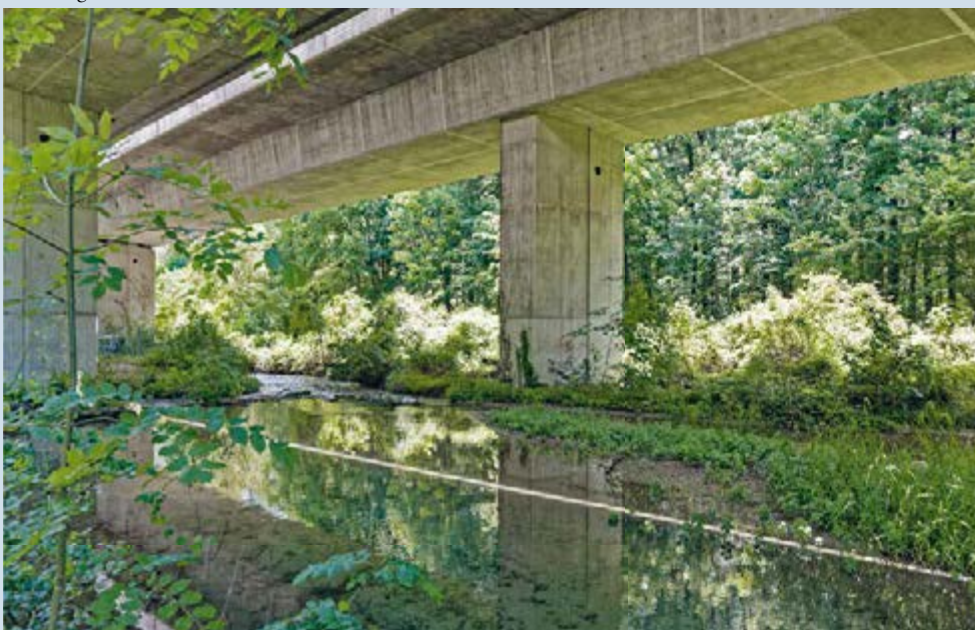
30 Aareviadukt in Schinznach-Bad, 2021. Unter dem umstrittenen Aare-Übergang der N3 zwischen Bözberg und Wülpselberg (Habsburg) entstand in den 1990er-Jahren als Ersatz für die gerodete Waldschneise eine ökologische Ausgleichsfläche mit Pioniercharakter.
