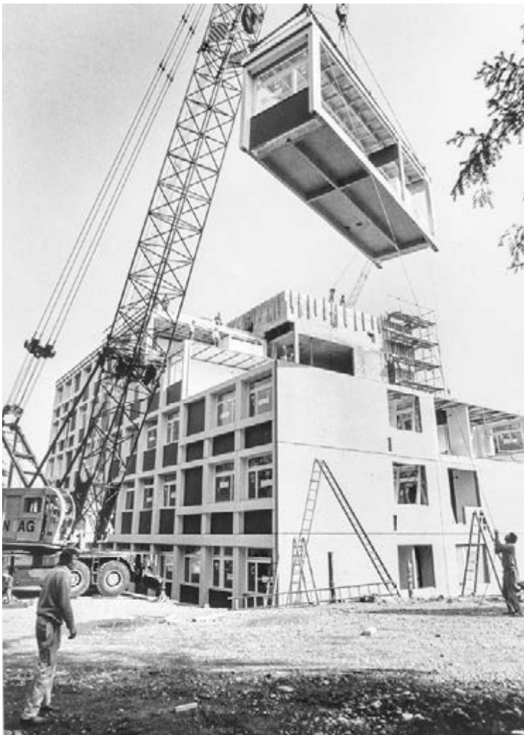
66 Montage des in Villmergen und Auw produzierten Raumzellensystems Variel beim Bau der Neurochirurgie im Kantonsspital Aarau, 1973. Variel-Elemente verliessen die Fabrik als fixfertige, schiffscontainergrosse Raumzellen, die auf dem Bauplatz aufeinandergestapelt werden konnten.
