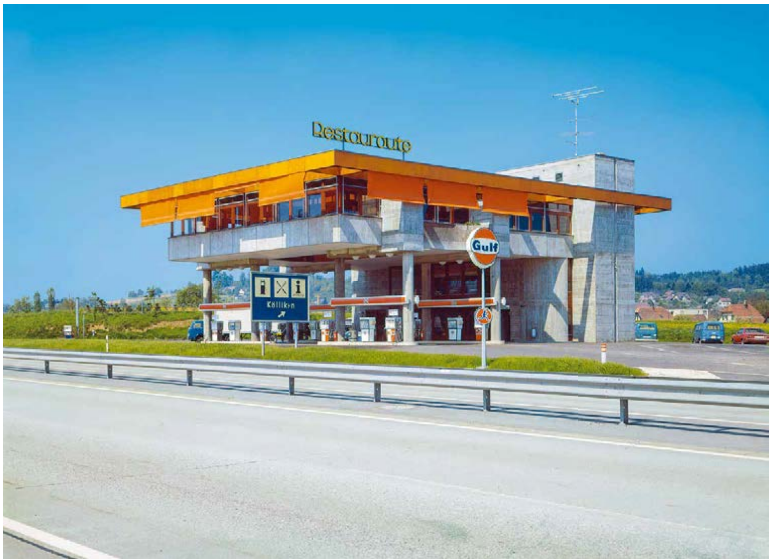
87 Autobahnraststätte Kölliken Nord, eröffnet im Herbst 1970. Der imposante Sichtbetonbau hat die Form einer halben Brücke. Stützen tragen das grosse Restaurant, welches so zum Dach der darunterliegenden Tankstelle wird.
