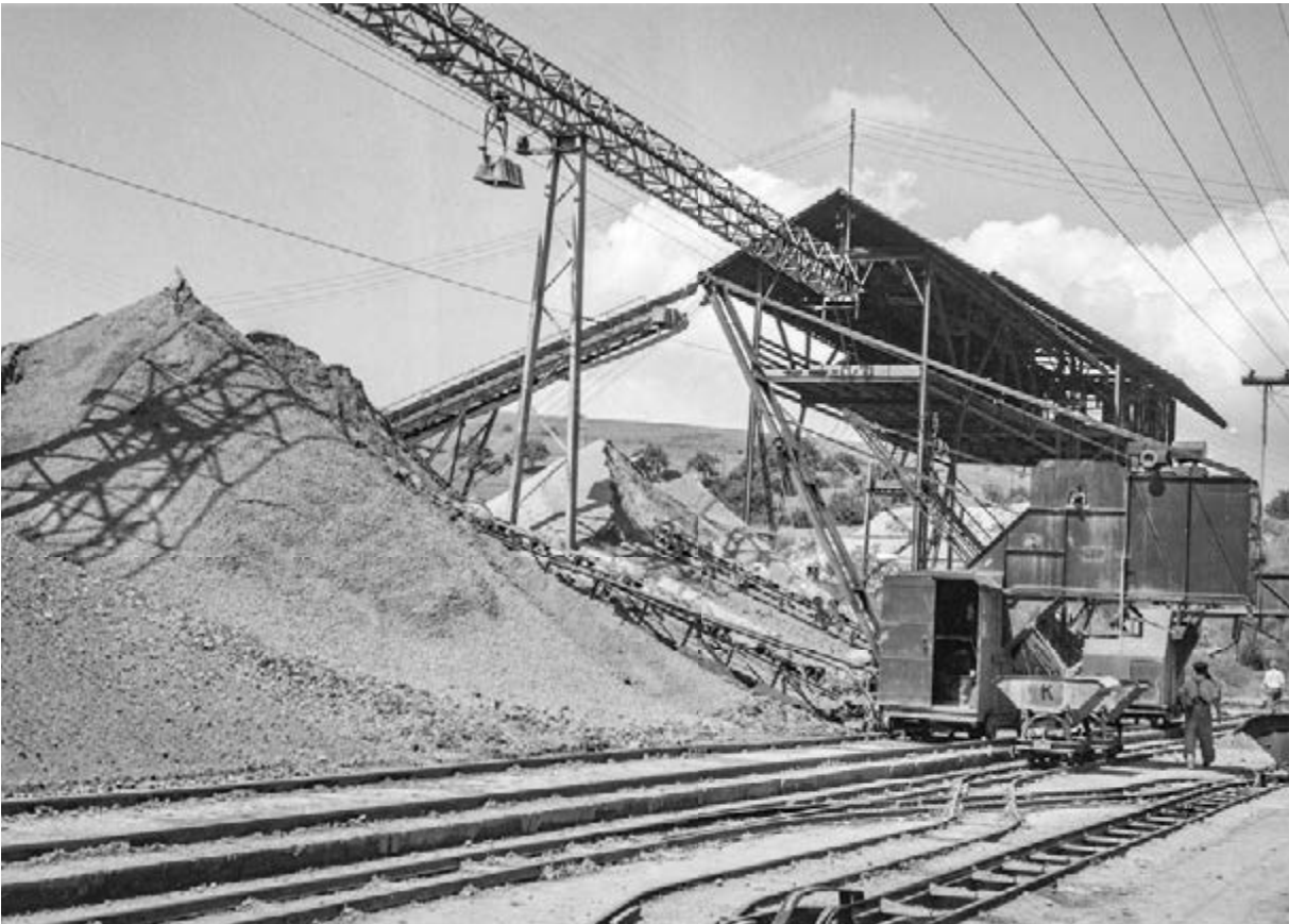
45 Materialseilbahn der Ziegelei Frick, 1953. Die 1,2 Kilometer lange Umlaufmaterialbahn wurde 1935 gebaut und ist die einzige verbliebene Bahn ihrer Art im Aargau. Sie transportiert Opalinuston von der Grube zum Verarbeitungswerk. Der Anlage wird im Schweizer Seilbahninventar als technisches Bauwerk nationale Bedeutung beigemessen.
