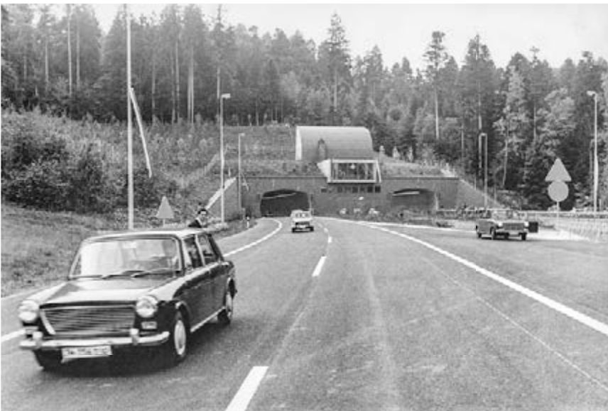
35 Baregg auf Neuenhofer Seite, 1970. Der 1,1 Kilometer lange Bareggtunnel wurde am 7. Oktober 1970 eröffnet. Er entwickelte sich bald zum Nadelöhr und zum wiederkehrenden Begriff in den Verkehrsnachrichten. Die täglichen Pendlerstaus waren berüchtigt. Nach der Eröffnung der N3 im Birrfeld erfolgte der Ausbau. Eine zusätzliche Röhre mit drei Spuren wurde 2003 dem Betrieb übergeben.
