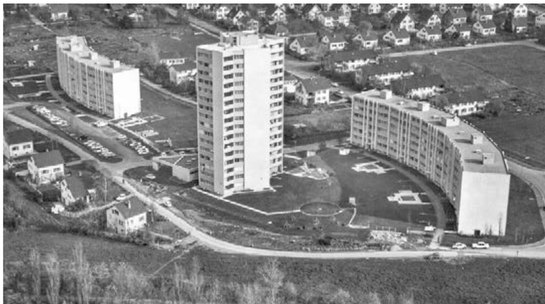
67 Siedlung Bodenacker Brugg. Die Siedlung ist mit 170 Wohnungen ein Beispiel für eine kleine unter den grossen Siedlungen. Als Werksiedlung für die in Brugg domizilierte Georg Fischer AG entstand sie zwischen 1960 und 1962, ihr 16-geschossiges Punkthochhaus war damals das höchste Wohngebäude im Kanton.
