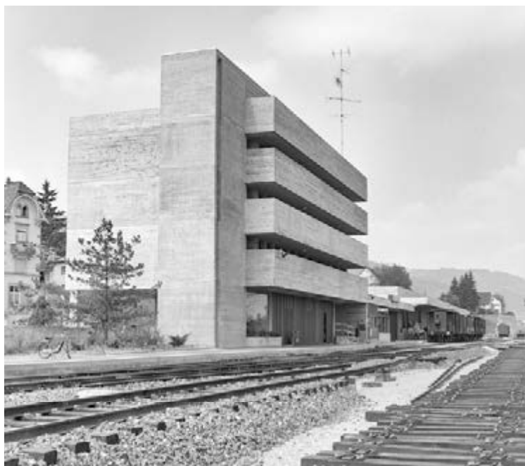
59 Bahnhof Killwangen. Ein skulpturaler Betonbau von SBB-Architekt Max Vogt, erbaut 1970.
