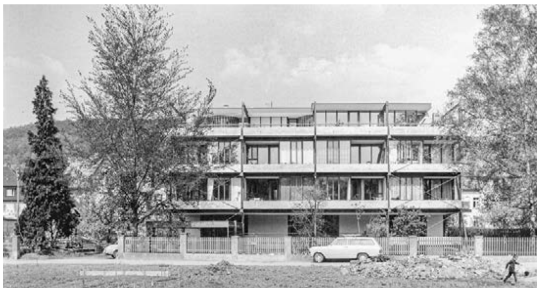
79 Das Haus Geissberger in Wettingen. Der nach dem Bauherrn Werner Geissberger bald «Geissburg» genannte Pionierbau aus Stahl und Glas wurde mit grossen Pflanztrögen ausgestattet, welche die Fassaden zu schattenspendenden hängenden Gärten machen.
