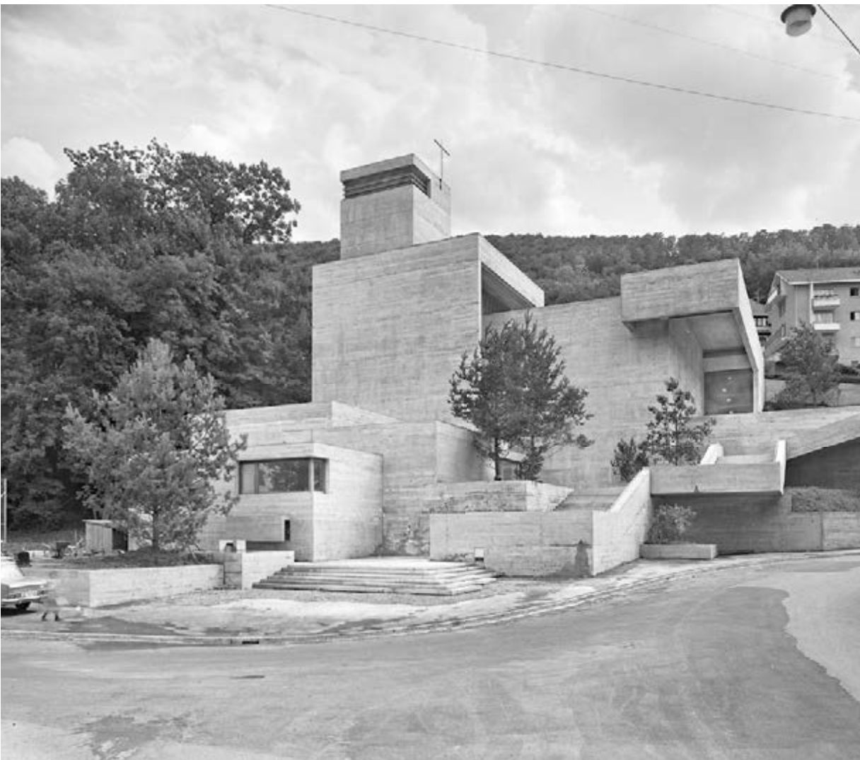
61 Die katholische Kirche St. Michael in Ennetbaden des Basler Architekten Hermann Baur. Das ebenfalls dem rohen Beton verpflichtete Gotteshaus wurde 1966 gebaut.
