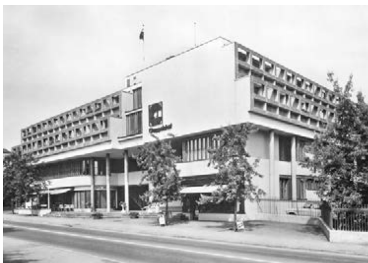
92 «Chappellehof» Wohlen. Das 1967 realisierte Pfarreizentrum ist die bauliche Umsetzung des zweiten Vatikanischen Konzils. Das Werk des Architekturbüros Beriger aus Wohlen umfasste eine Vielzahl von Gemeinschaftsfunktionen, vom Restaurant mit Saal und Kegelbahnen zu Vereinsräumen, Bibliothek sowie Alterswohnungen.
