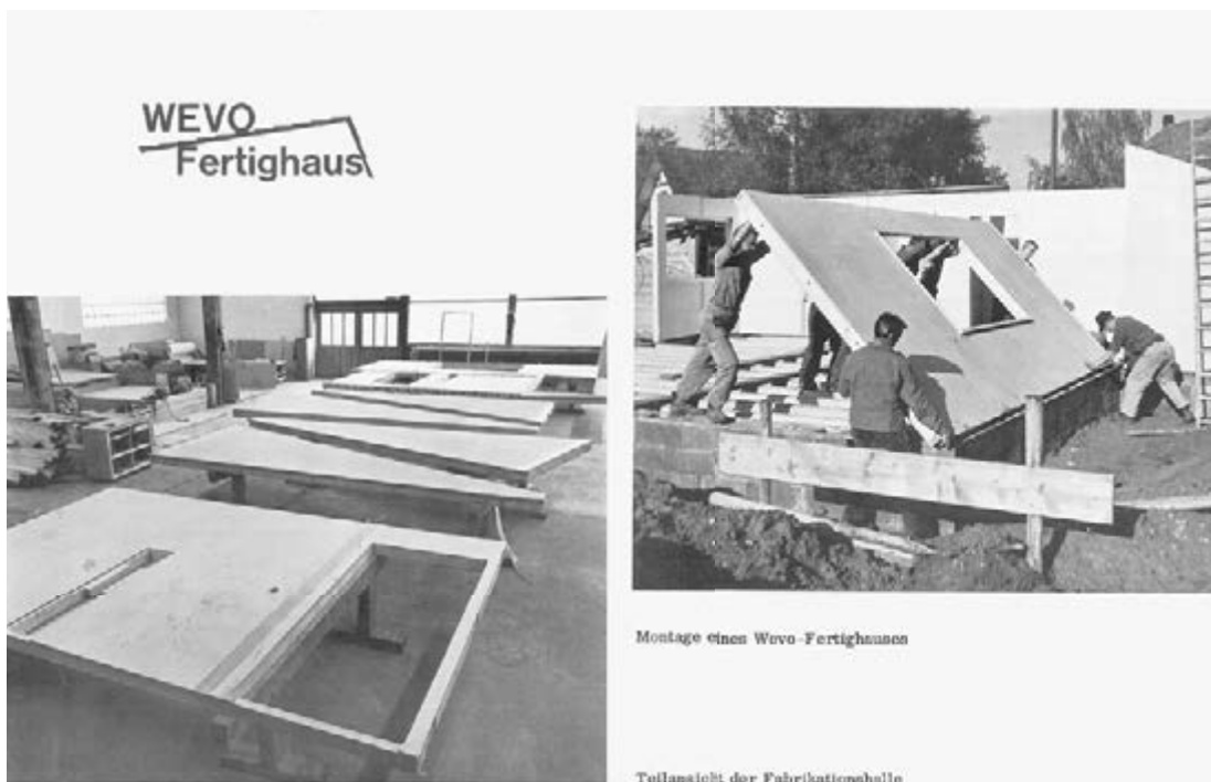
282 Wevo-Fertighaus-Katalog Anfang der 1960er-Jahre. Durch Vorfabrikation in der trockenen Halle und eine beschränkte Auswahl von Normtypen gelang es Werner Vögeli (*1926), in Leibstadt günstig und schnell Fertighäuser aufzustellen. Die Holzplatten lieferte die ortsansässige Firma Thermopal.
