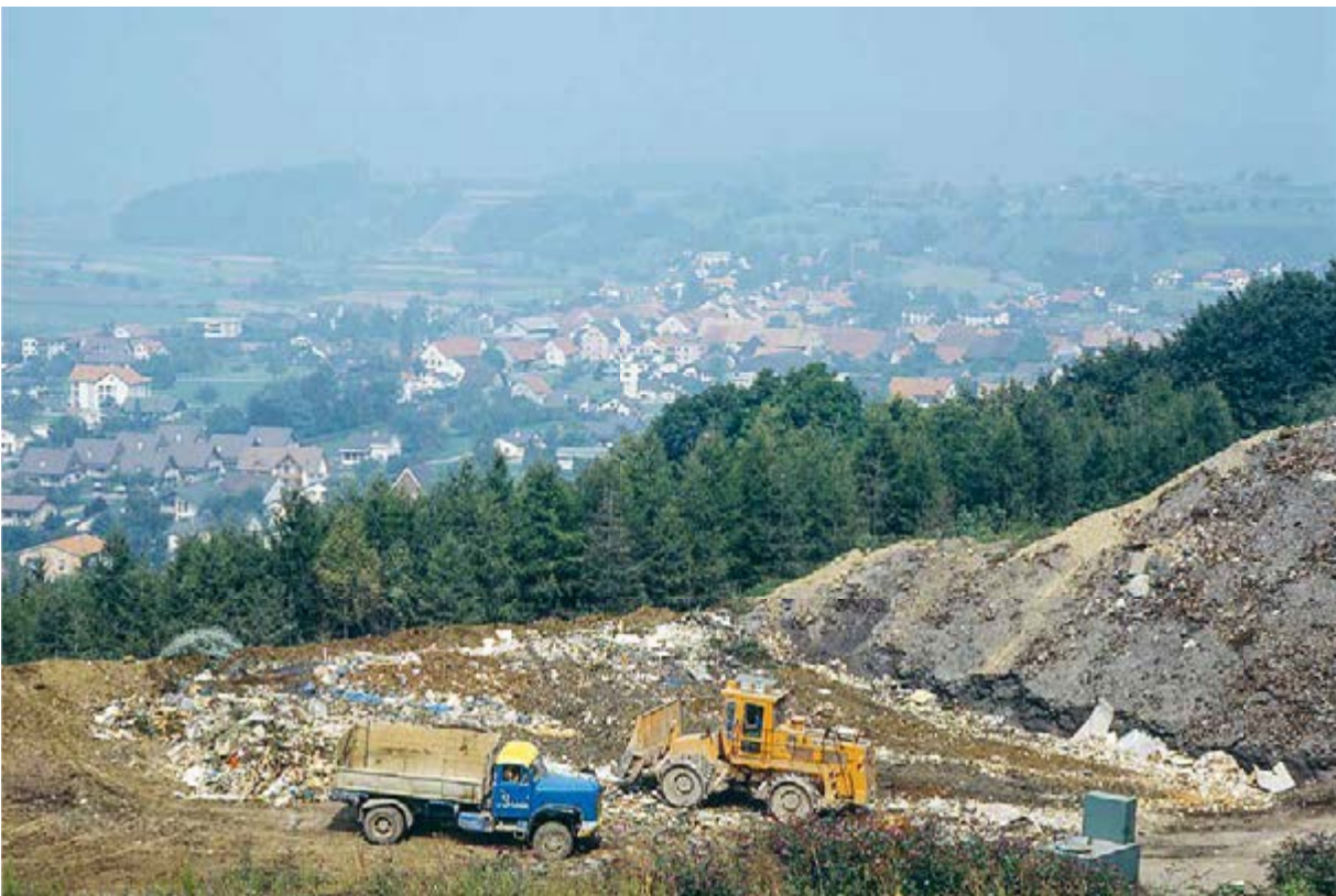
103 Deponie «Bärengaben» in Würenlingen, 1986. Die grösste Deponie des Kantons wurde 1964 als Provisorium eröffnet und bis 2011 betrieben. Der alte Steinbruch wurde hauptsächlich mit Sperrgut aus der Region Baden-Brugg, zeitweise auch mit giftigen Sonderabfällen – zum Teil illegal – aufgefüllt.
