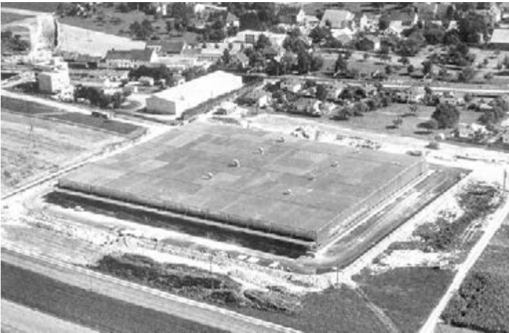
323 Verteilzentrale Denner in Mägenwil, 1973. Optimale Verkehrslage mit Autobahn- und Bahnanschluss machten das Dorf begehrt als Standort für grossflächige und verkehrsabhängige Industrie- und Gewerbebetriebe.
