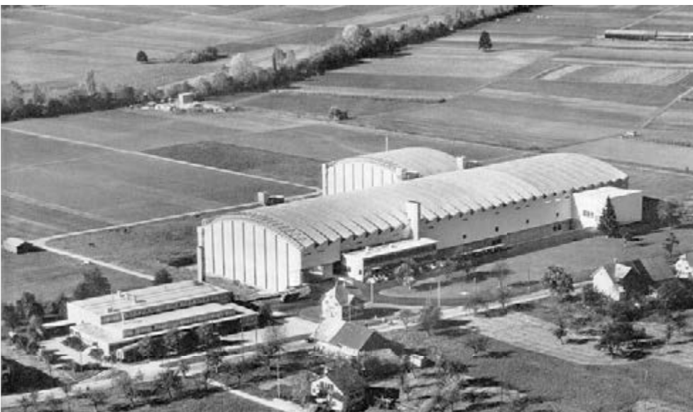
291 Die Aluminium AG Menziken war 1968 mit einem jährlichen Ausstoss von 12 000 Tonnen das zweitgrösste Leichtmetall-Halbzeugwerk der Schweiz. Das in den Jahren 1964/65 errichtete Werk in Reinach (im Bild) war für den Drei-Schicht-Betrieb ausgelegt worden, doch die Fremdarbeiterbestimmungen ermöglichten danach nur noch den Ein-Schicht-Betrieb.
