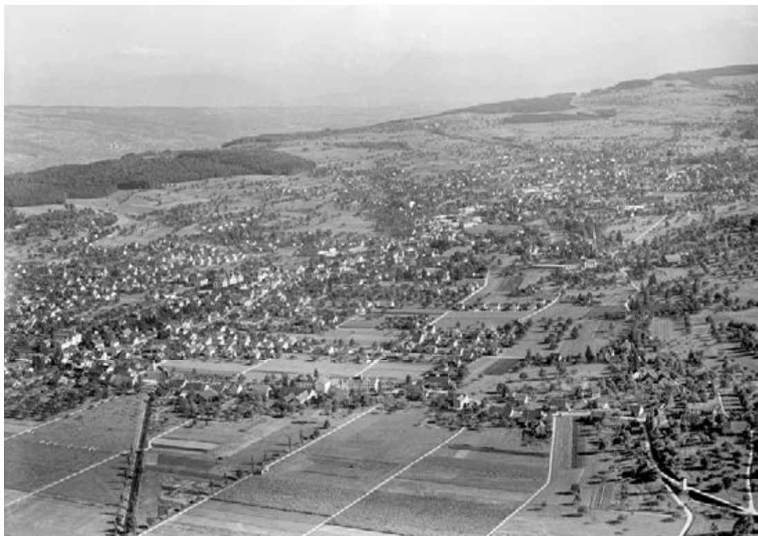
272 Flugaufnahme von Menziken und Reinach, 1945. Die Industrialisierung wandelte den Charakter der Aargauer Landschaft. Industriebauwerke mit Hochkaminen und ausgedehnte Wohnquartiere prägen das Erscheinungsbild des industriellen Aargaus.
