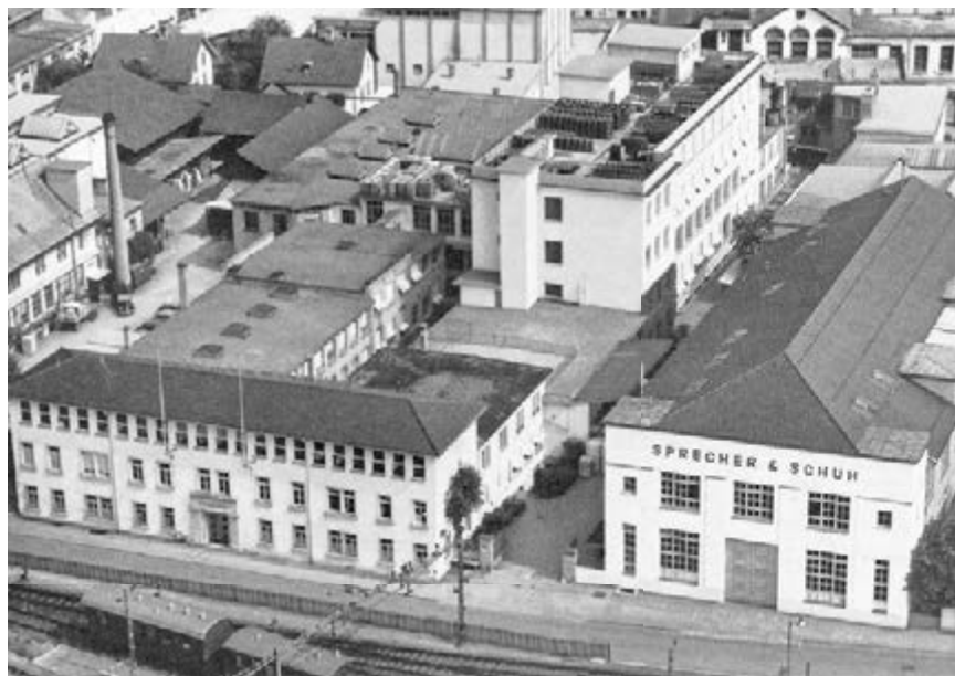
330 Hauptsitz von Sprecher + Schuh in Aarau, vor 1965. Trotz hervorragender Produkte wurde es im gesättigten Markt der Elektrizitätsversorgung immer schwieriger, sich gegen die Konkurrenz im Ausland zu behaupten. Für Sprecher + Schuh war der Weltmarkt eine Schuhnummer zu gross geworden, das Abstossen einzelner Geschäftsbereiche ab Mitte der 1980er-Jahre versprach für diese mehr Entwicklungsmöglichkeiten.
