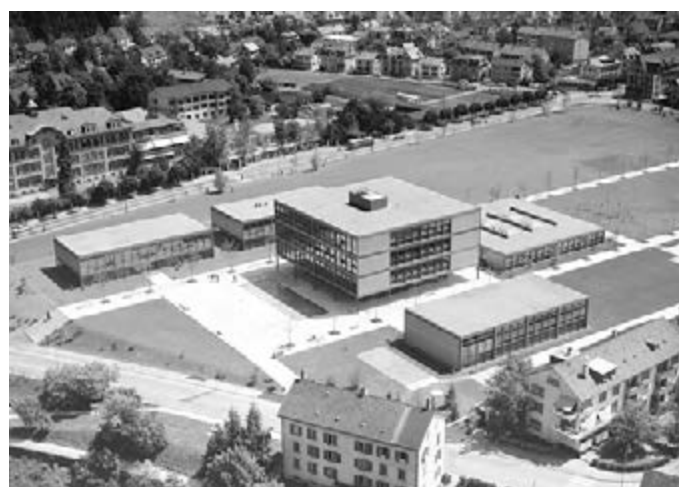
144 Die Kantonsschule Baden nach der Fertigstellung, 1964. Fritz Haller (1924–2012) legte ein Raster über das Grundstück und entwickelte daraus einen Schulcampus. Die Bauten bestehen aus einem sichtbaren Stahlgerippe, das mit Sichtbackstein ausgefacht wurde.
