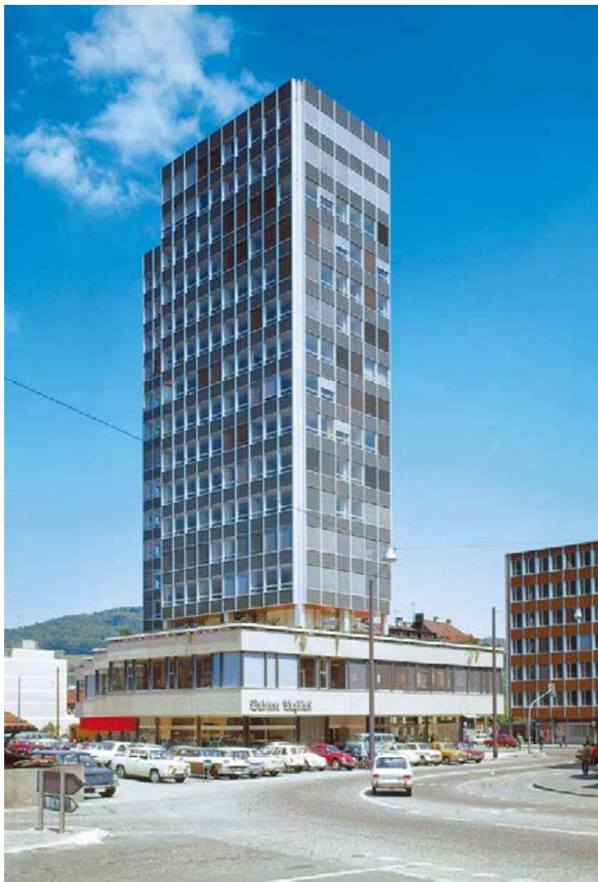
62 Das Hochhaus des Badener Tagblatts entstand im «international style» zwischen 1962 und 1969 nach Plänen der Architekten Bölsterli und Weidmann.
