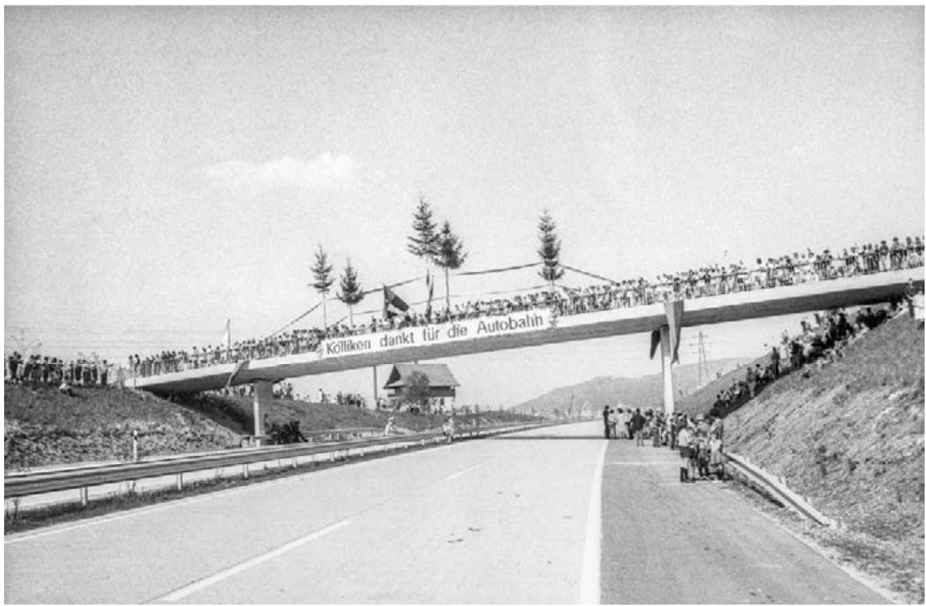
31 Eröffnung der Autobahn N1 am 10. Mai 1967. Auf der Autobahnbrücke feiert die Bevölkerung von Kölliken dicht gedrängt die Eröffnung des 84 Kilometer langen Teilstücks von Oensingen nach Hunzenschwil. Dabei winkt sie dem Automobilross um Bundesrat Tschudi zu.
