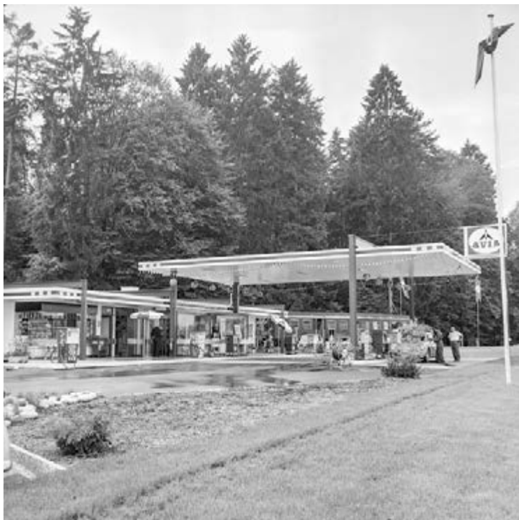
88 Kölliken Süd. Die 1967 eröffnete erste Autobahnreststätte der Schweiz in Kölliken Süd bestand aus einer standardisierten Avia-Tankstelle und einem ausrangierten Speisewagen der SBB. Dieser wurde 1972 durch einen Restaurantbau ersetzt.
