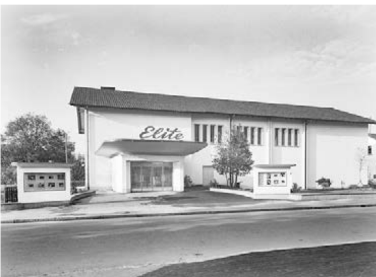
487 Das Kino Elite in Wettingen kurz nach seiner Eröffnung, 1947. Das Kino steht bis heute an der Landstrasse auf dem inzwischen dicht bebauten Wettinger Feld. 1997 erfolgte der Umbau in ein Triplex-Kino. 2022 wurde das Elite geschlossen.
