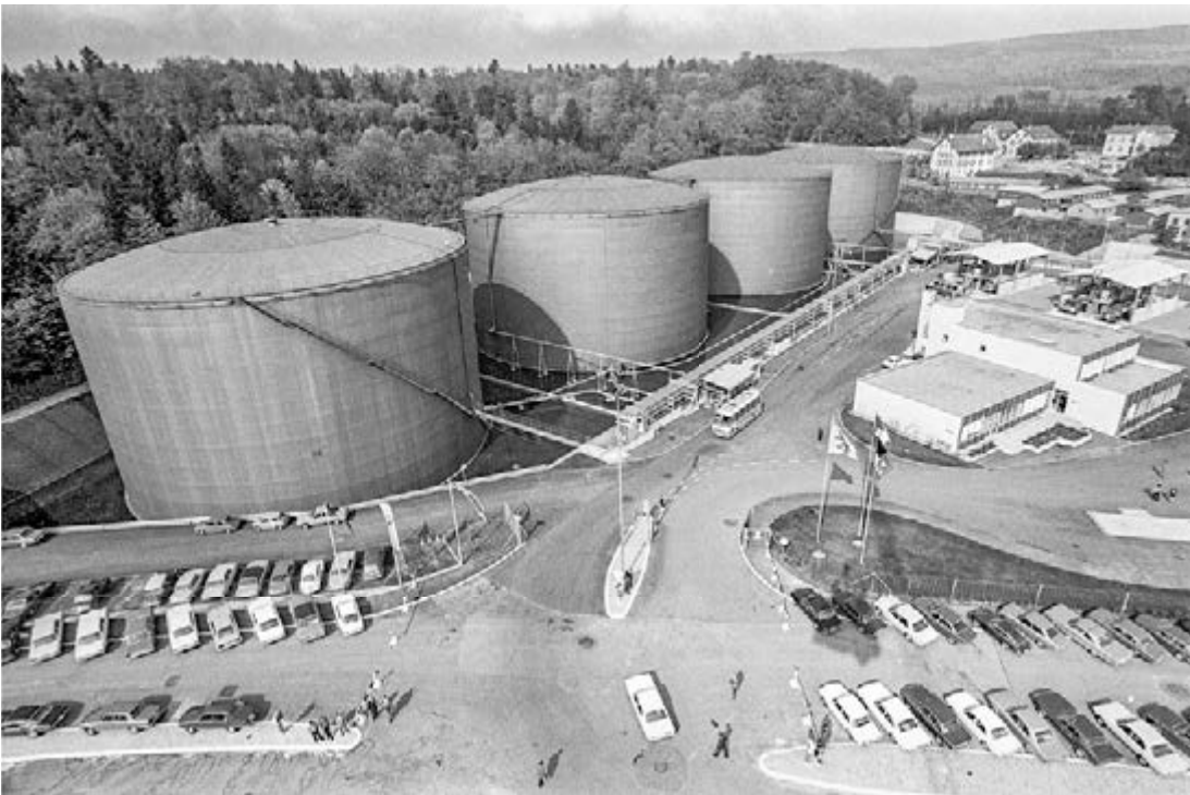
290 Ende der 1960er-Jahre stand das grösste Tanklager der Schweiz bei Mellingen. 25 Tanks enthielten 760 Millionen Liter Treib- und Brennstoff und konnten die gesamte Schweiz während eines Monats versorgen.
