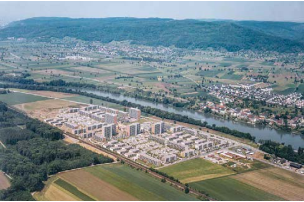
70 Die Grossüberbauung Augarten in Rheinfelden, Flugbild von 1975. Mit über 1000 Wohneinheiten wirkt die von den Architekten Gelpke & Düby geplante Siedlung dörflich, was an der eher geringen Arealausnutzung von 0,5 und an der Tatsache liegt, dass hier die Erdgeschosse überwiegend dem Wohnen mit privaten Gärten vorbehalten sind.
