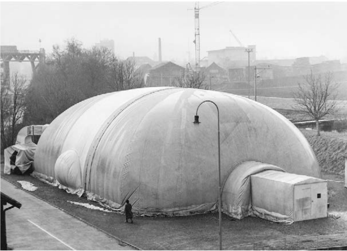
285 Innovation der Schweizerischen Leinen-Industrie (SLI) in Niederlenz, 1964. Die Traglufthalle Arova versprach Flexibilität. Sie diente als Lager-, Montage-, Messe- oder als Tennishalle. Die SLI baute die Traglufthallen nach eigenen Plänen und Berechnungen. Sie waren wasserdicht, liessen sich beheizen und beleuchten und waren schnell aufgestellt.
