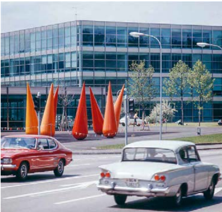
51 Baudenkmal von nationaler Bedeutung: Technikum Windisch von Fritz Haller (1924–2012). Das 1966 fertiggestellte Hochschulgebäude gehört zu den Ikonen der modernen Schweizer Architektur.
