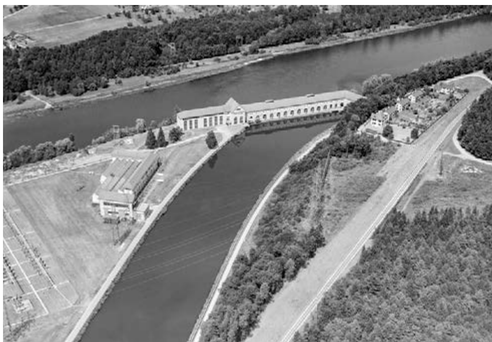
295 Kraftwerk Beznau, 1964. Die frühe Nutzung des Wasserreichtums begründete den Ruf des Energiekantons Aargau. Das Laufkraftwerk Beznau aus dem Jahr 1902 legte den Grundstein für die NOK. Zusammen mit dem Speicherkraftwerk Löntschi bildete es schon früh einen Verbund, der Bandenergie mit Spitzenenergie aus Speicherseen ergänzte.
