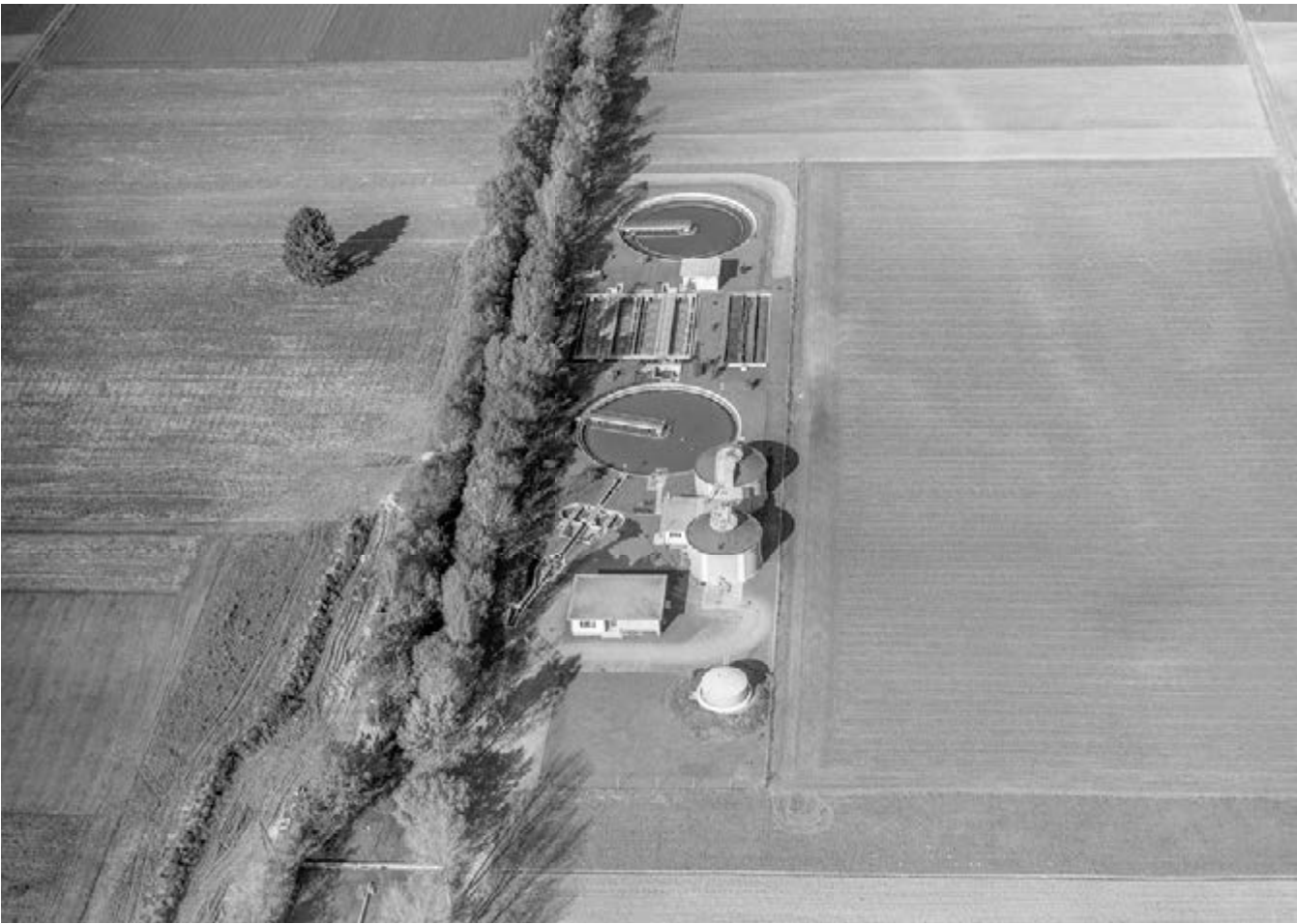
99 Kläranlage Oberwynental, Reinach 1962. Der Bau von Kanalisationen und Kläranlagen stellte für die Gemeinden eine Herausforderung dar. Im oberen Wynental schlossen sich Reinach, Menziken, Burg und Pfeffikon (LU) bereits in den 1930er-Jahren zu einem Zweckverband zusammen. 1962 konnte die erste mechanisch-biologische Abwasserreinigungsanlage im Kanton Aargau in Betrieb genommen werden.
