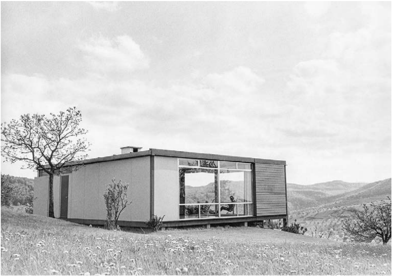
65 Vorfabriziertes Wochenendhaus in Magden, 1960. Das vom Zürcher Architekten und Designer Alfred Altherr jun. entworfene Ferienhaus über den Reben von Magden gehört zu den frühesten Prototypen für Elementbauweise in der Nachkriegszeit.
