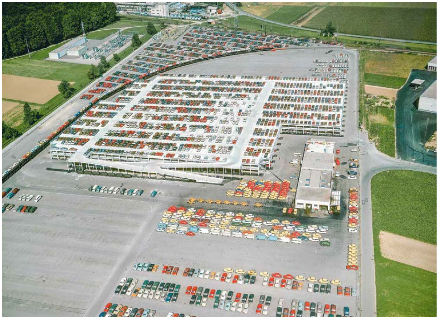
86 Neuwagenlager der Amag in Lupfig, 1971. Heute führt die 1996 eröffnete Autobahn A3 mit dem Vollanschluss Lupfig unmittelbar am 1965 in Betrieb genommenen Autolager vorbei, das auch über einen eigenen Bahnanschluss verfügt.
