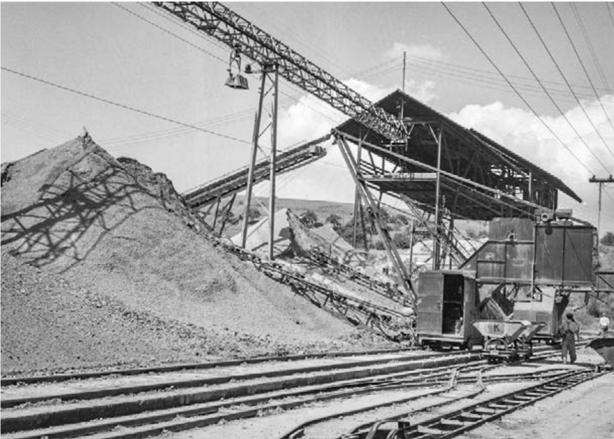
45 Materialseilbahn der Ziegelei Frick, 1953. Die 1,2 Kilometer lange Umlaufmaterialbahn wurde 1935 gebaut und ist die einzige verbliebene Bahn ihrer Art im Aargau. Sie transportiert Opalinuston von der Grube zum Verarbeitungswerk. Der Anlage wird im Schweizer Seilbahninventar als technisches Bauwerk nationale Bedeutung beigemessen.
