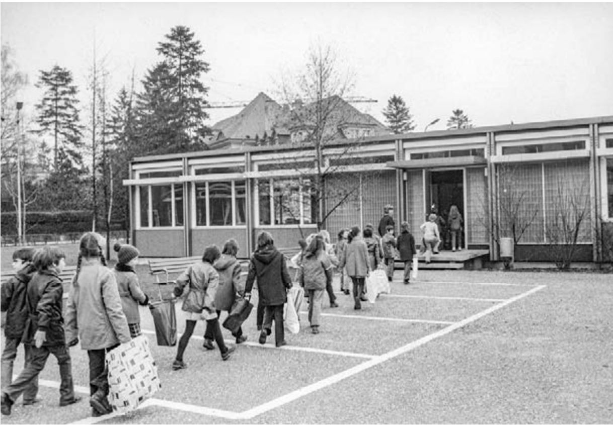
138 Die Stadt Brugg setzte 1973 Schulpavillons ein, um genügend Platz für Kindergarten und Primarschule zu schaffen.
