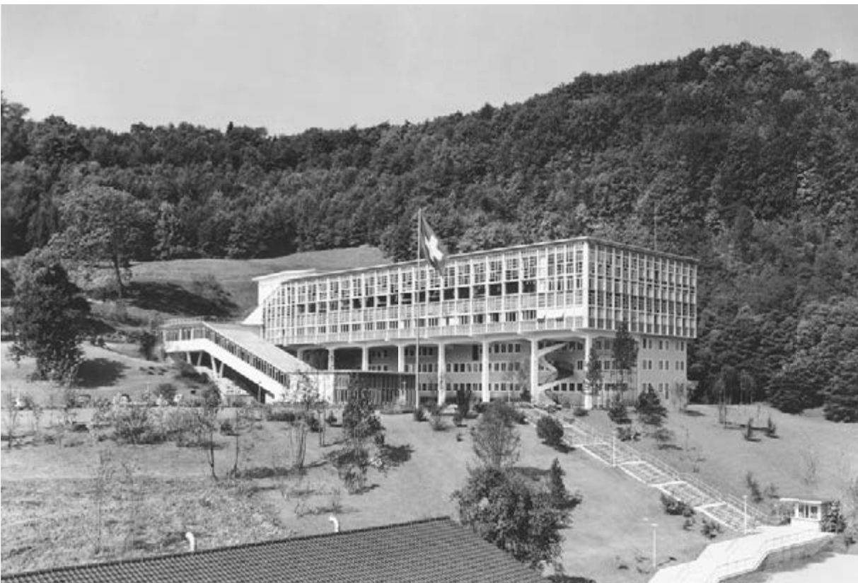
52 Baudenkmal von nationaler Bedeutung: das BBC-Wohlfahrtshaus am Martinsberg Baden von Armin Meili. Es wurde 1952 eröffnet und 2006 durch Burkard Meyer Architekten denkmalgerecht zum heutigen Berufsbildungszentrum umgebaut.
