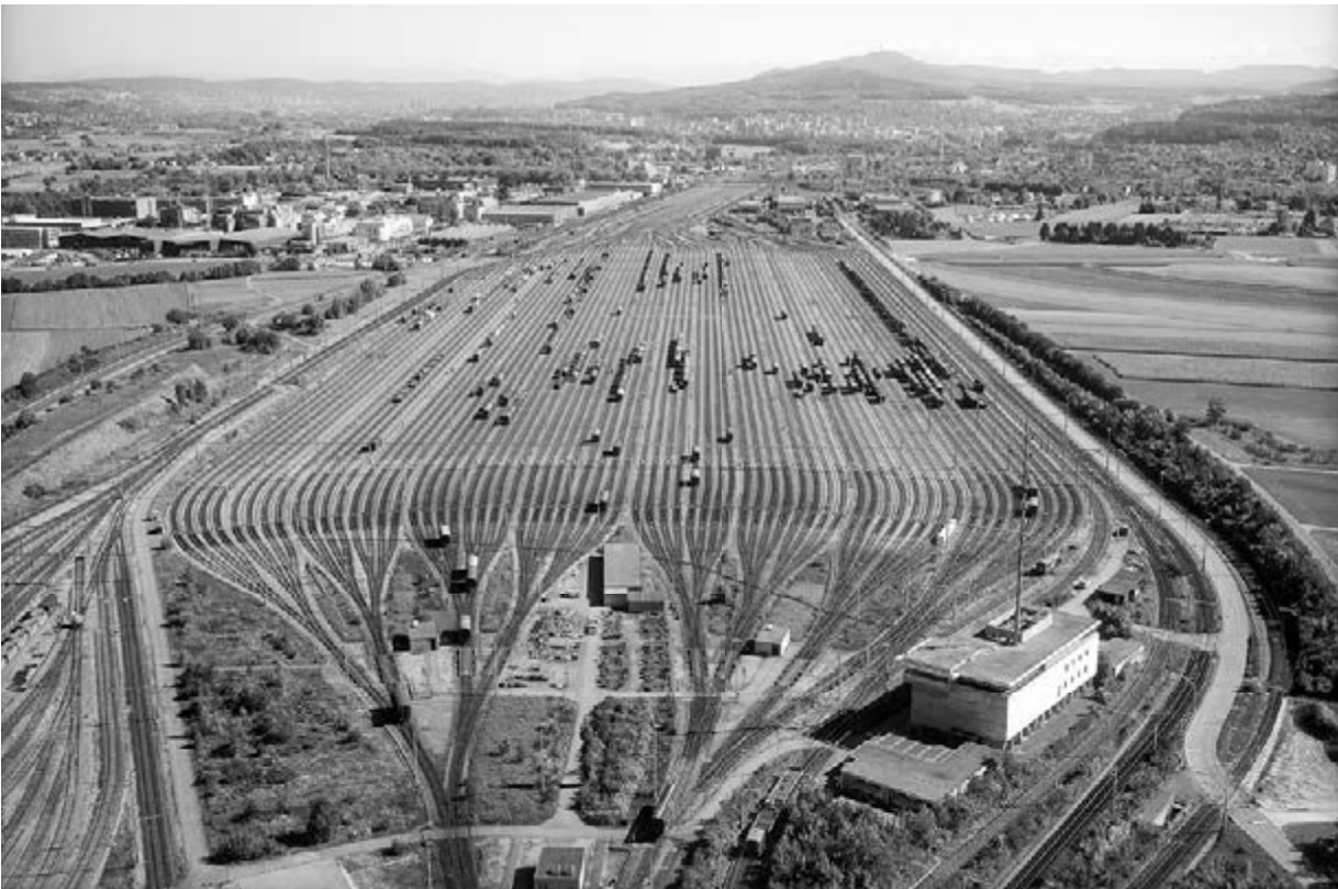
44 Der Rangierbahnhof Limmattal, um 1990. Die Anlage gehört in Europa zu den grössten und leistungsfähigsten ihrer Art. Sie umfasst 120 Kilometer Gleis auf einer Fläche von rund 1,2 Quadratkilometern.
