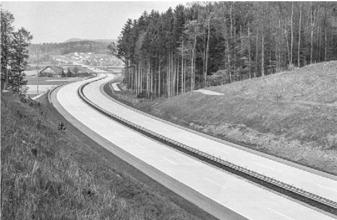
33 Schweizer Autobahnbelagsföderalismus: Der Abschnitt der N1 zwischen Rothrist und Zürich wurde durch die Verwendung von Betonplatten als Fahrbelag zur schweizweit bekannten Holperpiste. Den Entscheid für weissen Belag (Beton) fällte der Regierungsrat entgegen den Empfehlungen der Ingenieure des Nationalstrassenbüros. In der Bildmitte der Übergang über die Wyna bei Gränichen.
