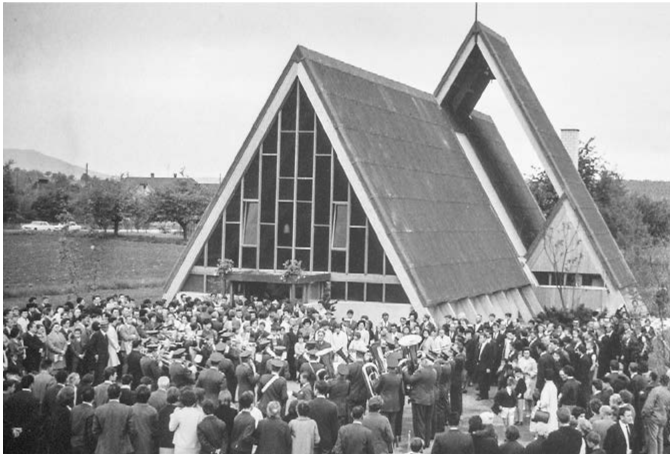
90 Einweihung der Pauluskirche Lupfig, 1966. Die Kirche entstand aus vorfabrizierten Elementen innerhalb von sechs Monaten als schlüsselfertiger Prototyp zum Preis von 300 000 Franken. Seit 2020 steht der einst provisorische Bau unter kantonalem Denkmalschutz.
