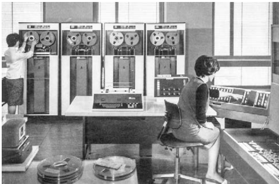
319 Die BBC besass 1964 die grösste und leistungsstärkste Datenverarbeitungsanlage der Schweizer Industrie. Die Operatrice hantiert an der Magnetbandeinheit, die sitzende Kollegin bedient die Technikonssole. Das Unternehmen rationalisierte mit der Anlage die Lohnbuchhaltung.
