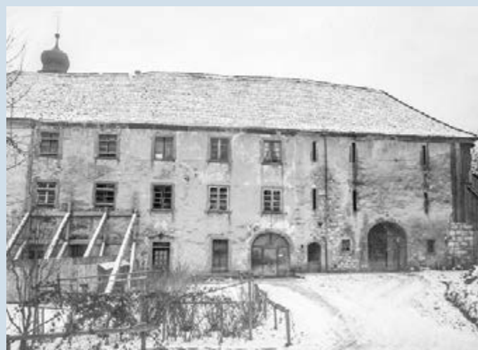
419 Diese Aussenansicht der Propstei Wislikofen dokumentiert den verfallenen Zustand der Gebäude vor der Renovation 1972.
