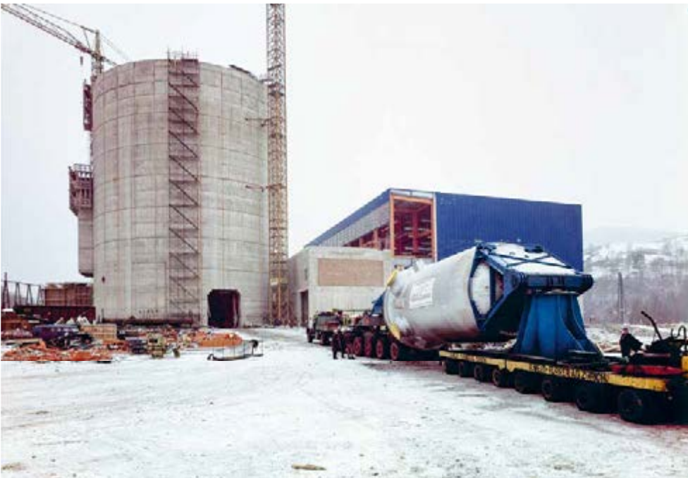
301 Geplant, bewilligt, gebaut: Die Erstellung des ersten Atomkraftwerks Beznau I dauerte von der Ankündigung 1964 bis zur Eröffnung fünf Jahre. Das Bild zeigt die Lieferung des Reaktors der amerikanischen Firma Westinghouse 1967. Es ist heute das älteste in Betrieb stehende AKW der Welt.
