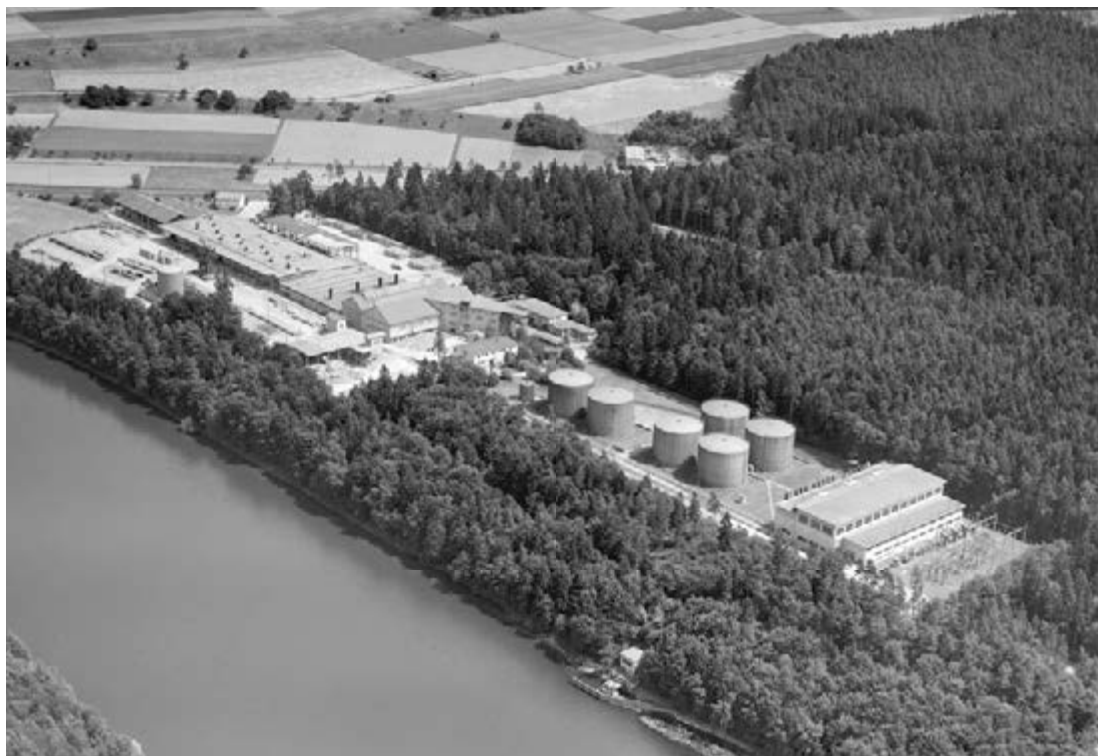
294 Das thermische Kraftwerk mit Öltanks 1964, links davon das Tonwerk. Um Bedarfsschwankungen auszugleichen, erstellte die NOK in Dörtingen, vis-à-vis des Flusskraftwerks Beznau, 1948 ein thermisches Kraftwerk mit vierzig Megawatt Leistung.
