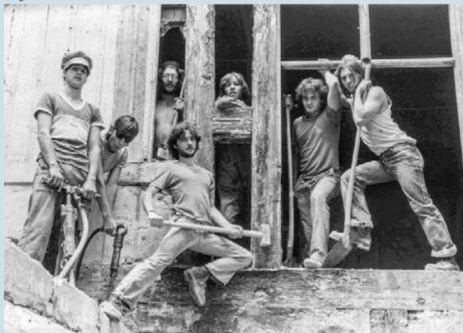
452 Eine Baugruppe begann 1982 den Zofinger «Ochsen» umzubauen. Der ehemalige Gasthof diente anschliessend dreissig Jahre lang der selbst verwalteten, kulturorientierten Genossenschaft als Veranstaltungsort.
