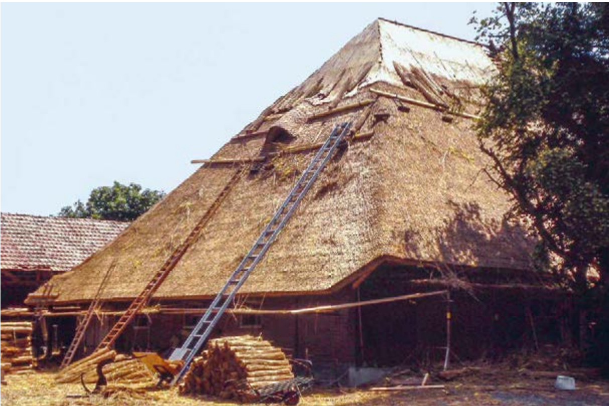
544 Restauration des 1802 erbauten «Salzmehus» (Salzmannhaus) in Kölliken zu Beginn der 1980er-Jahre. Als eines der letzten Strohdachhäuser im Aargau wurde es neu mit Schilf gedeckt. Es ist ein Kulturgut nationaler Bedeutung und steht unter Denkmalschutz.
